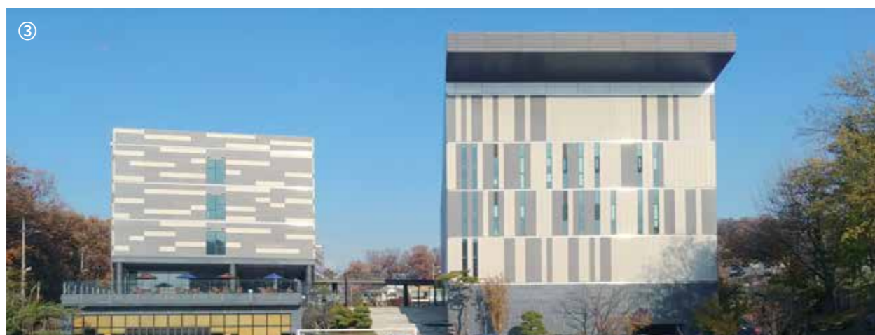
① • 공사명 : 경인아라뱃길 경인항여객터미널 • 주소 : 인천광역시 서구 정서진1로 41 ② • 공사명 : 완주보건소 • 주소 : 전라북도 완주군 삼례읍 수계리 590-6 ③ • 공사명 : YBM연수원 • 주소 : 경기도 화성시 정남면 세자로 317
