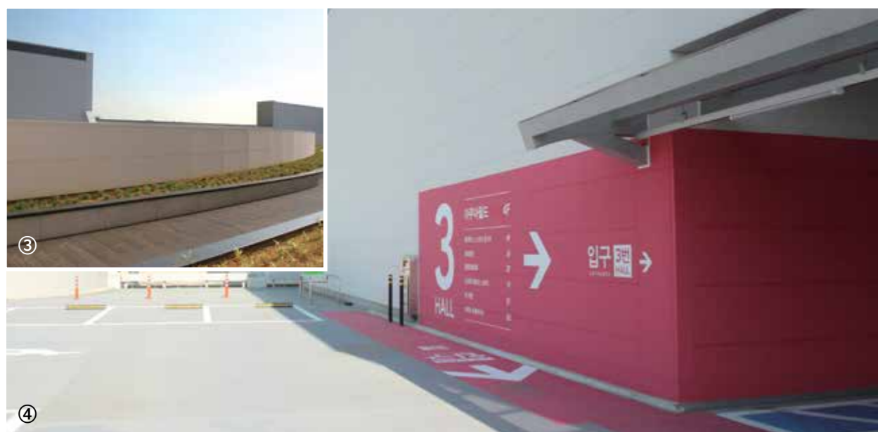
①② •공사명 : 벽산 흥성공장 •주소 : 충청남도 홍성군 갈산면 산단로388번길 100 ③④ •공사명 : 고양삼송 스타필드 •주소 : 경기도 고양시 덕양구 고양대로 1955
