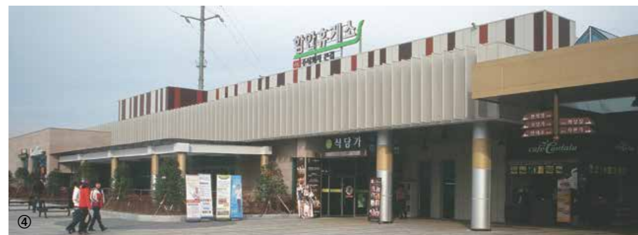
①② •공사명: 안양 RFHIC 빌딩 •주소: 경기도 안양시 동안구 부림로170번길 41-14 ③④ •공사명: 함안(순천방향) 휴게소 •주소: 경상남도 함안군 군북면 현포로 205-1 •설계: 신도시건축
